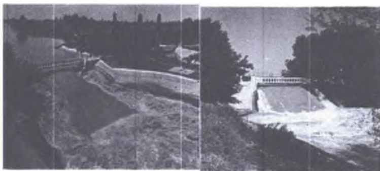
5.12 - rasmi. Katta Farg'ona kanali Norin uchastkasidagi sharsharlar
