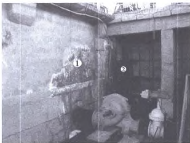
7.1- rasm. Nasos stansiyasi ichida devor sirtida hosil bo'lgan g'uborlanish (1) va oqish dog'i (2).
