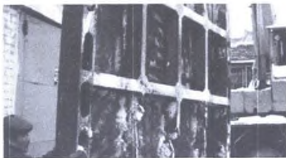
3.3 - rasm. Do'stlik kanalini PK 260 va PK 580 da joylashgan gidrouzellarga o'rnatilgan zatvorlarda yuz bergan korroziya hodisasi
