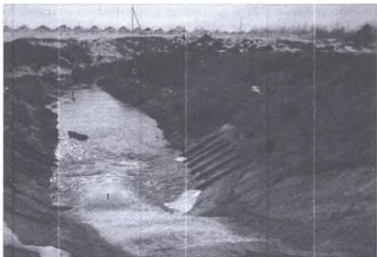
8.4 - rasm. Ta'mirlashdan so'ng g'adir-budurli perepad pastki befida qolib ketgan beton bo'lagi (1) va uning ta'sirida qiyshaygan oqim hosil bo'lishi jarayoni, hamda qiyshagan oqim urilib ochilib qolgan risberma uchastkasi (2) va suv olib ketuvchi kanalni yuvilgan uchastkasi (3) (10.01.2007 y.).
