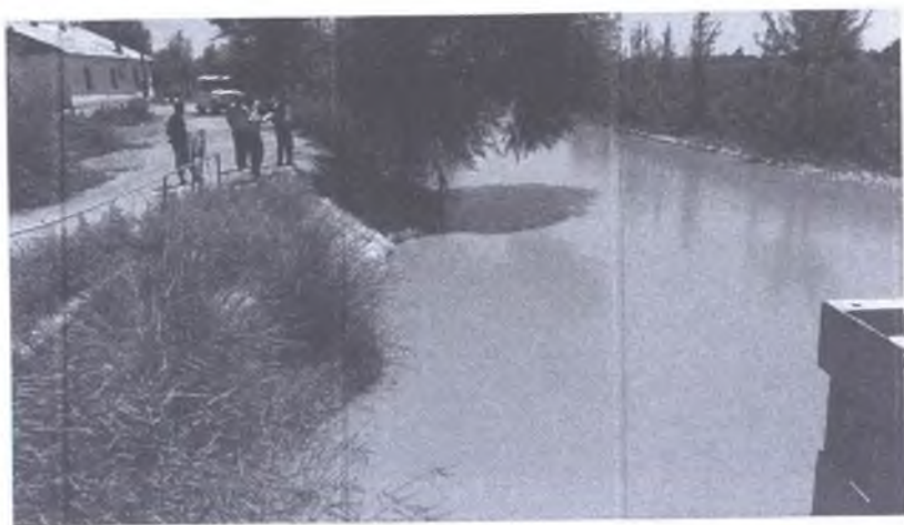
5.6 - rasm. Mang'it arna kanalida oqayotgan suvning ko'rinishi
